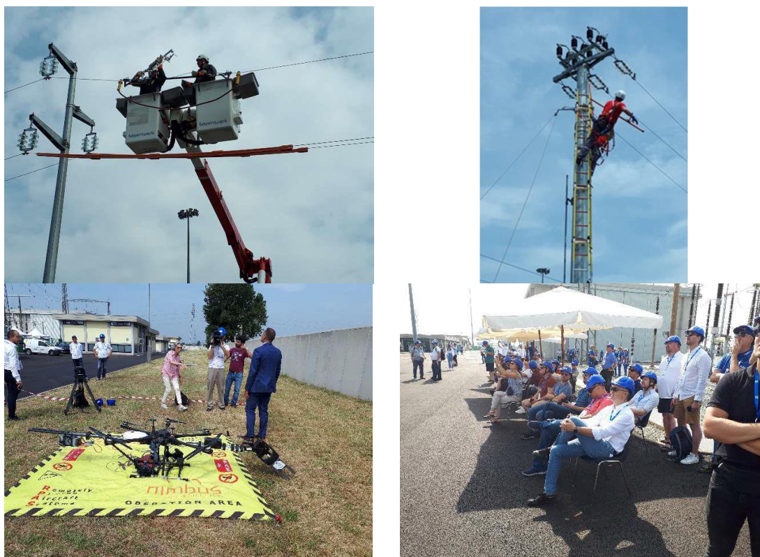
Rys. 8. Pokazy prac pod napięciem na i w pobliżu włoskiej stacji 400/225/63 kV Rondissone (źr. www.icolim.org ); po raz pierwszy ustawiono krzeselka i parasole do obserwacji prac
