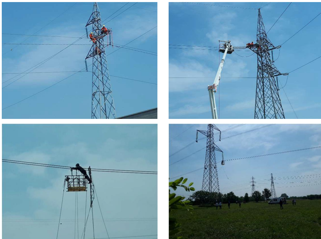
Rys. 10. PPN na liniach 132, 225 i 400 kV wykonywały ekipy z różnych krajów
