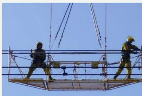
Kosze zawieszane pod helikopterem na czas wykonywania zadania
