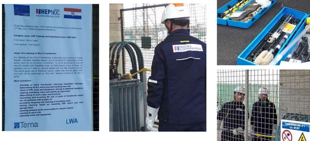
Rys. 9. Praca brygad z Chorwacji polegała na czyszczeniu stacji SN zestawem firmy Dehn
